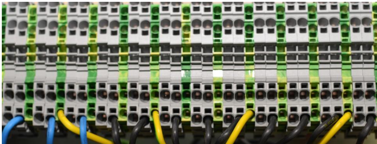
Рисунок 2.3.13. Верхняя панель с клеммами выводов RPCM DELTA (фрагмент).
