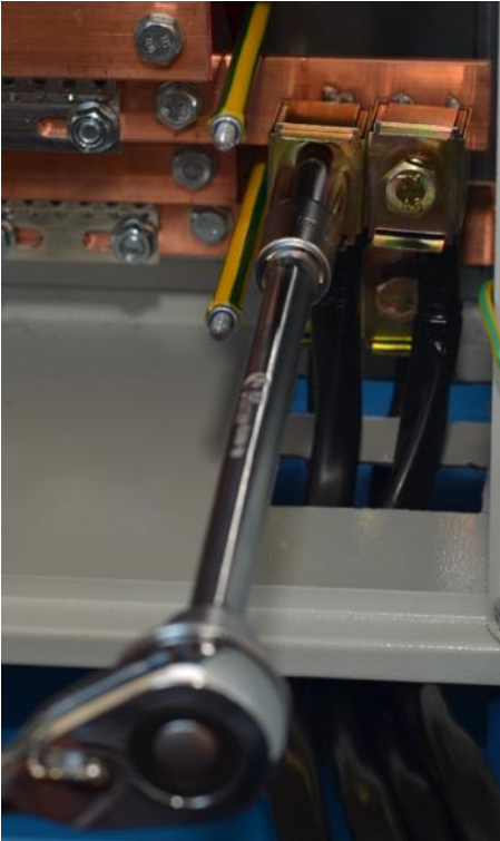
Рисунок 2.3.7. Подключение кабеля к клеммам на вводе (для контраста показан светло-серый фон корпуса).
