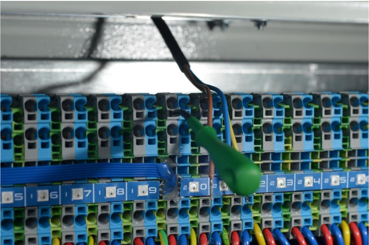
Рисунок 2.3.16. Инструмент для монтажа кабеля вставлен в клемму.
